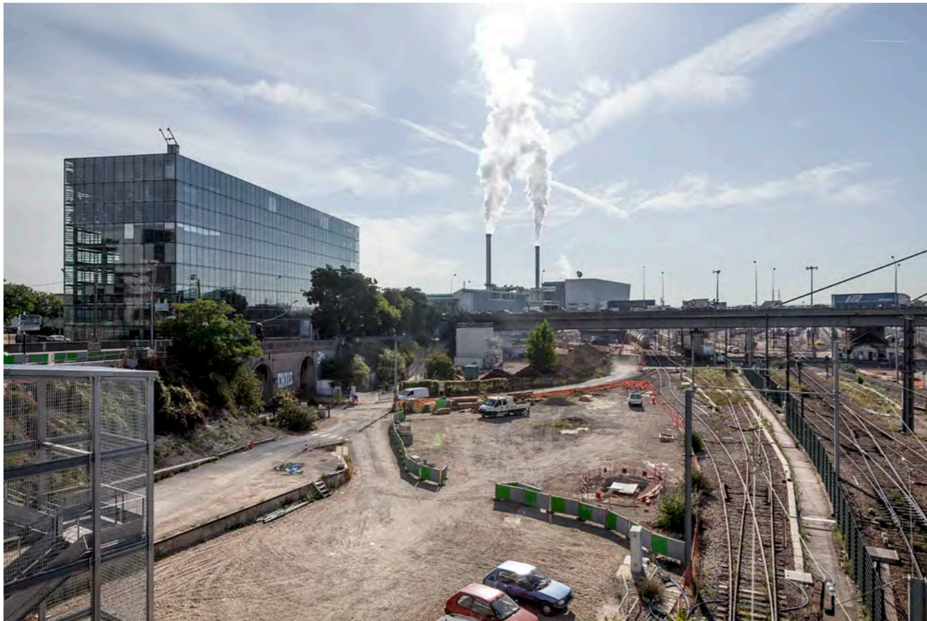
Vue d'ensemble de l'état actuel du site
