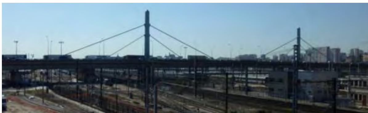
Pont à haubans du boulevard périphérique au-dessus du faisceau de la gare d'Austerlitz
