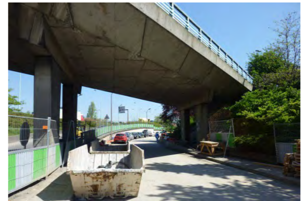
7- Talus végétalisé de l'échangeur
