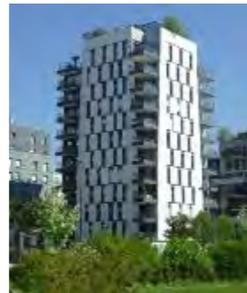
3 - Immeuble rue Thomas Mann
