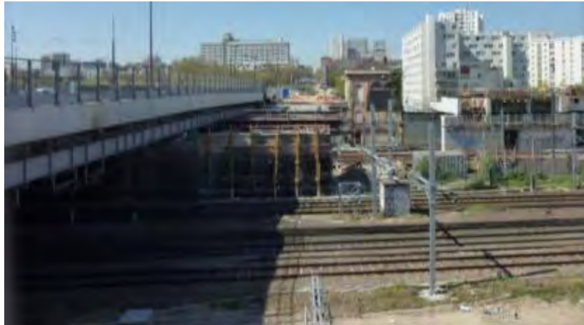
Les voies SNCF en cours de couverture au niveau du Boulevard Jean Simon
