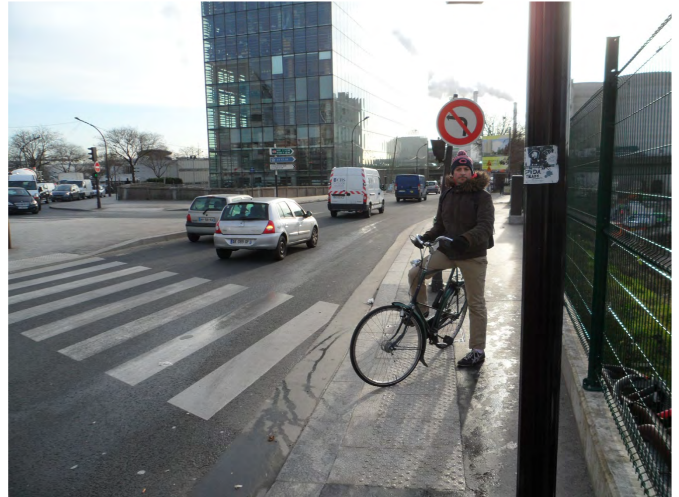
Absence d'aménagement cyclable sur la rue Bruneseau (vue du carrefour entre la rue Bruneseau en face, le Bd Jean Simon derrière et la rue Berlier à gauche)
