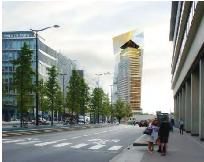
Projet DUO façades nord-ouest et nord-est vues depuis l'avenue de France
