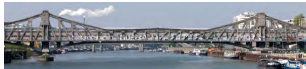
Passerelle industrielle d'Ivry à Charenton (dite « passerelle aux câbles ») Sources : Conseil régional d'Ile-de-France
