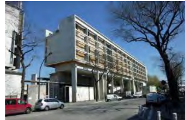
3- Résidence étudiante et foyer de jeune travailleur rue Bruneseau
